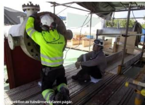
Inspektion av tubvärmväxlaren pågår.
